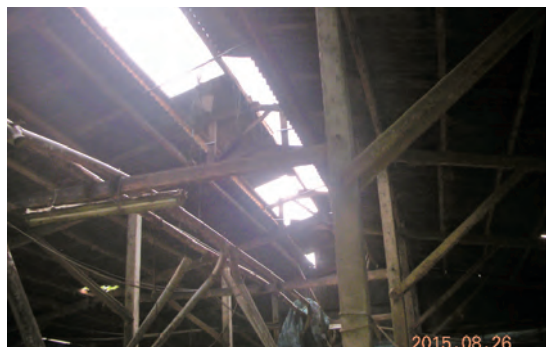
圖 3. 半倒（僅屋頂破損而房舍樑柱結構完整未受損）
