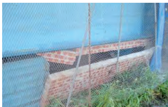
圖 4. 半倒（磚牆密閉畜禽舍毀損如有屋頂破損、牆壁倒伏而房屋結構未受損）
