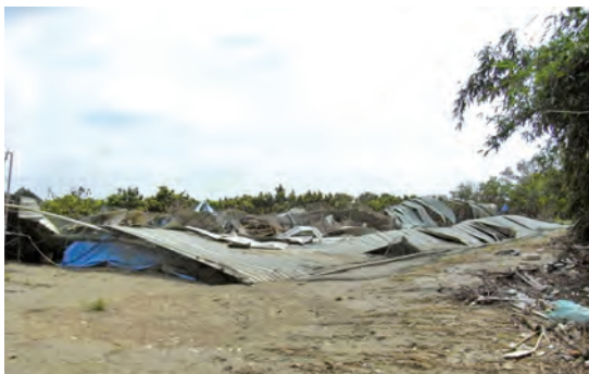
圖 1. 全倒（房舍結構受損達全棟）
