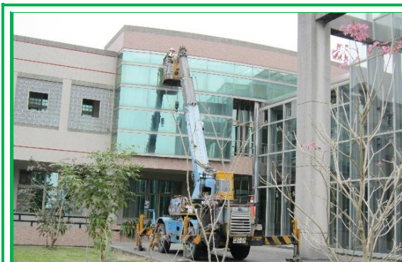
生理組大樓玻璃牆幕漏雨修繕／劉振發 提供
