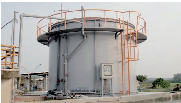
▲ 100 噸直立式厭氣發酵槽外觀
