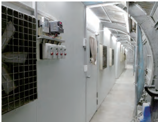
▲透過密閉飼養及 HEPA 濾網進行換氣以維生物安全
