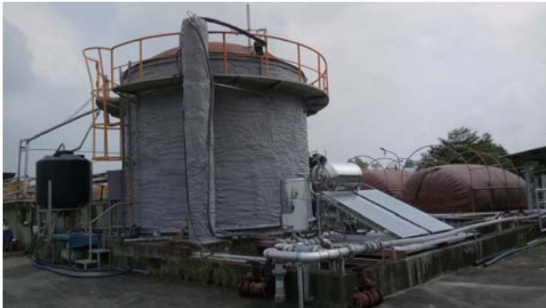
▲直立式厭氧發酵槽包覆保溫層及太陽能加熱設施
