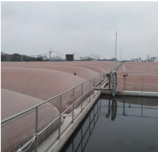
▲大型養豬場建置之臥式厭氧發酵槽
