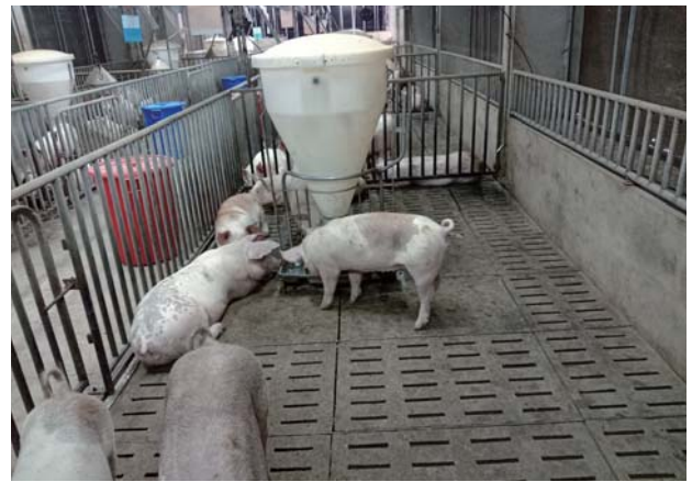
▲豬舍床面結構—預鑄鋼筋混凝土板
