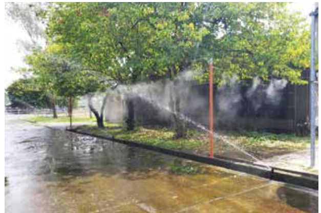
▲戶外預降溫系統可以大幅降低入風口空氣溫度。
