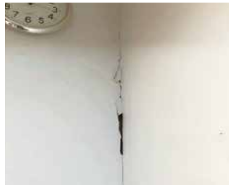
震後發現辦公室牆面有龜裂及油漆剝落情形 / 洪靖崎 提供 (114/1/20)
