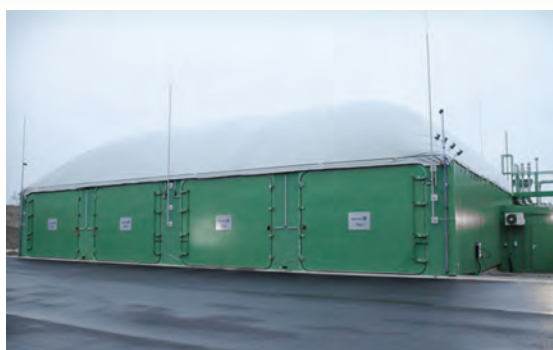
▲圖1. 乾式厭氧消化封閉式產沼氣槽體，該系統可視為傳統堆肥的升級改善未來式
